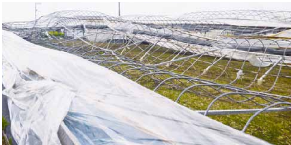
◀台風に伴う竜巻で倒壊したハウス（平成26年7月11日、香美市にて）
