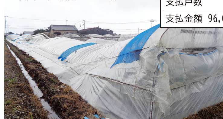
▼ 台風6号の接近により全壊したハウス
